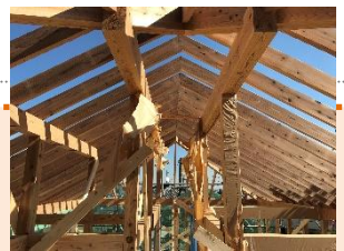
棟木のないすっきりとした小屋組みと、家の中に中庭をとりこんだ設計は必見です！
