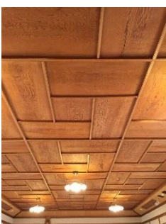
部屋の端-端まで継目なし、全長 9.5m の天井板!
